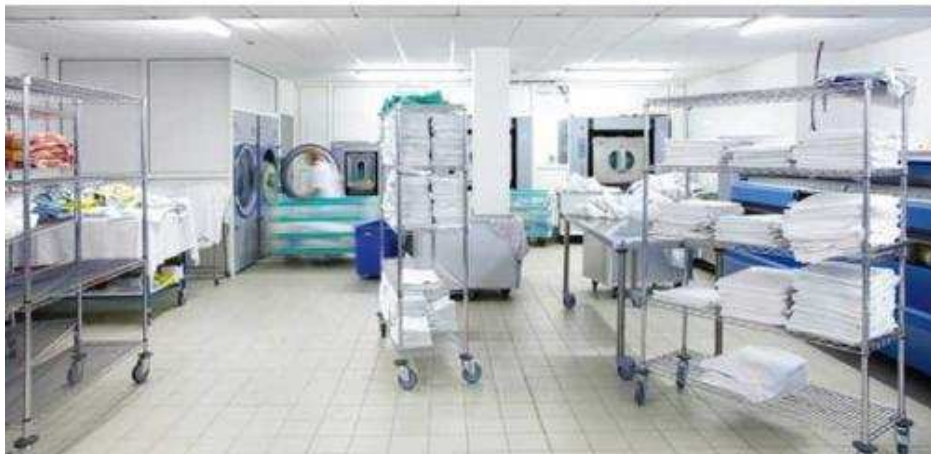
Attrezzature tipo per locale lavanderia/stireria
